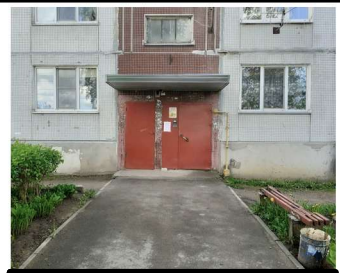
ПОДХОДЫ К ДОМАМ хорошее состояние покрытия
