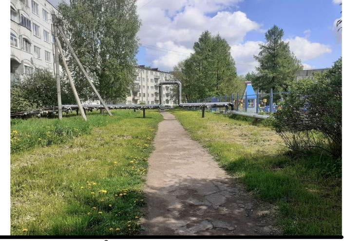
дорожка у дома 8, плохое состояние покрытия, инж. сети
